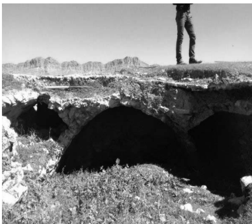
شکل ۷. نمونه‌ای از طاق‌های تپه‌زاغه؛ در دو طرف طاق اصلی از طاق‌های کوچک‌تری به منظور سبک‌سازی بنا استفاده شده است.
